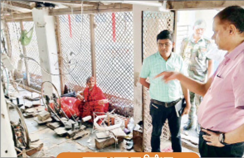
बुनकर भवन का निरीक्षण
